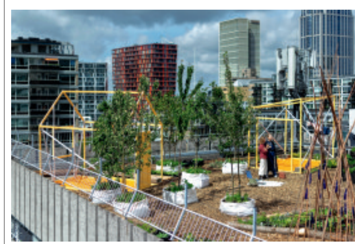
3. Konditaget Het dak als speel- en sportplaats. Konditaget (letterlijk: het conditiedak), in Kopenhagen, biedt een landschap van speeltoestellen voor jong en oud, boven op een complex met luxe appartementen.
